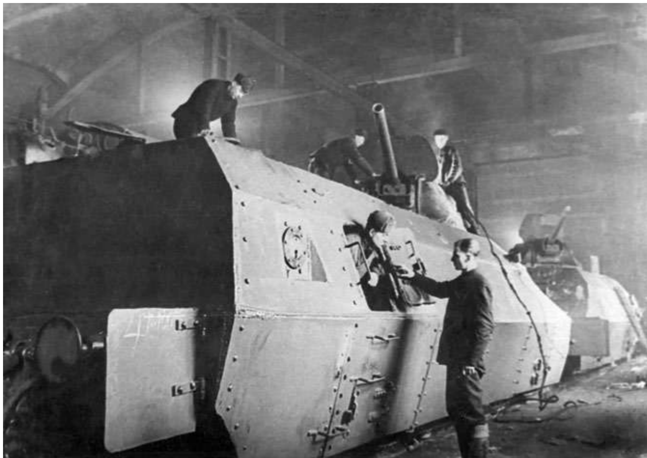
Строительство бронепоезда. 1941 год. Источник: pastvu.com/p/892745. Бронепоезд построили за месяц. Передача Красной армии бронепоезда, который по желанию его строителей получил название «Подольский рабочий», состоялась 1 января 1942 года. Подольский машиностроительный завод имени Орджоникидзе (ЗиО).
