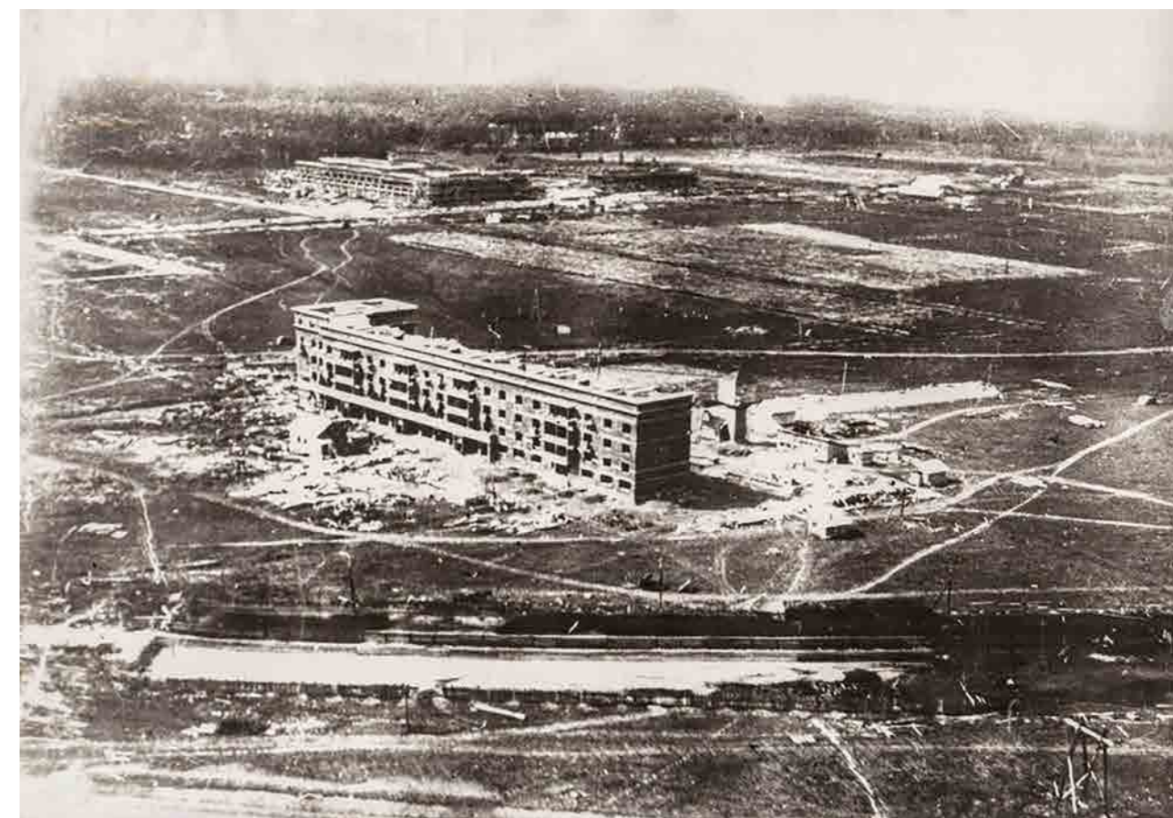
➤ Строительство «Аварийного дома» на фоне строительства комбината. 1934 год.
